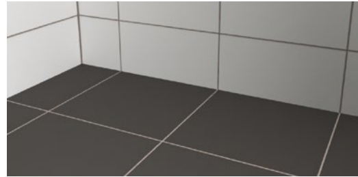
FIGUR 9 B. Fogar på golv och vägg är linjerade. Plattor på golv och vägg måste då vara modulanpassade.
