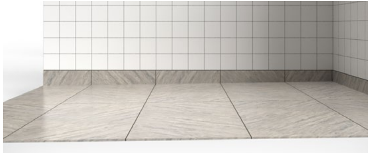
FIGUR 14 A. Sockelplattans övre kant ligger i våg.
