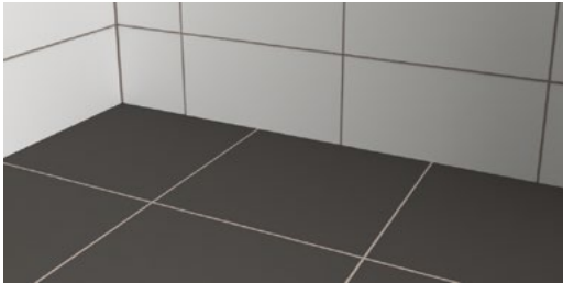
FIGUR 9 A. Fogar på golv och vägg avviker markant.
