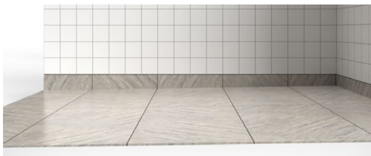
FIGUR 15 A. Sockelplattans övre kant ligger i våg.
