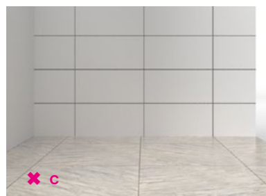
FIGUR 10 C. Fogar på golv och vägg avviker EJ markant.
