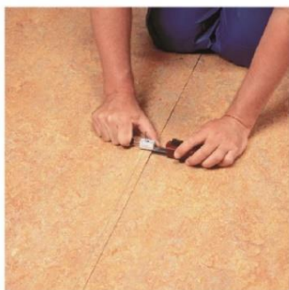
Nedfällning och kantskärning av linoleum
